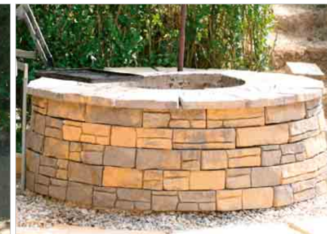
Rekonstrukció utáni állapot
