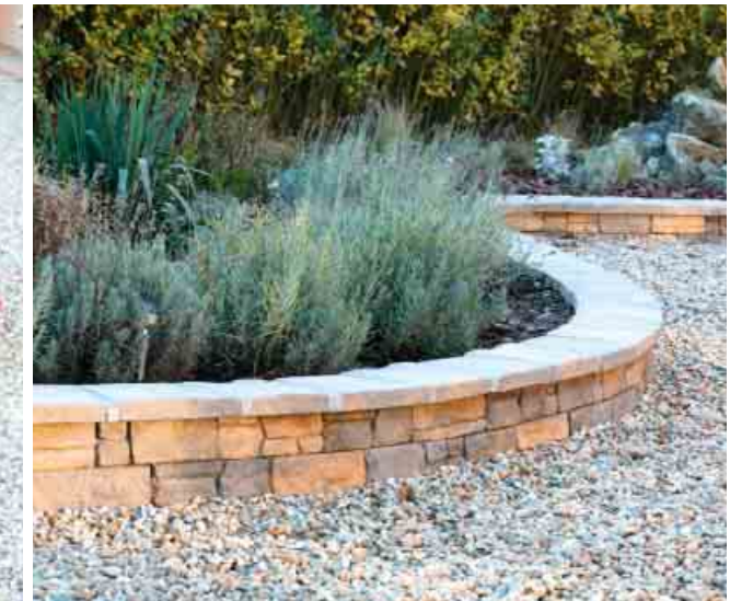
Rekonstrukció utáni állapot
